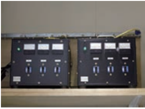
電気を効率的に使うために自動力率調整装置や電流 バランスーを設置
