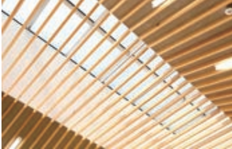
日射熱をカットし、採光するトップライト。夏でも熱さはほとんど感じない
