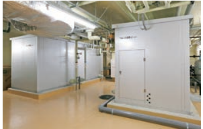
貯湯タンクを2台設置
