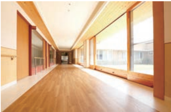
県産材ヒノキが内装に使用された広い廊下。この下にも床暖房があり、冬は優しい温かさを醸す
