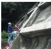
のり面の健全性評価試験
